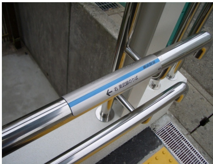
かいだんよう てんじひょうじ 階段用の点字標示
