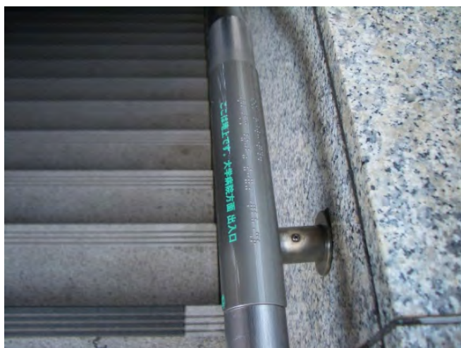
手すり点字標示
